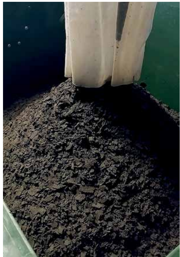
Выгрузка обезвоженного осадка
